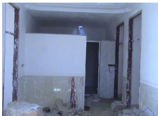
شکل ۷: افزایش تعداد اتاق‌ها، مسکن در حال ساخت، محمدآباد
