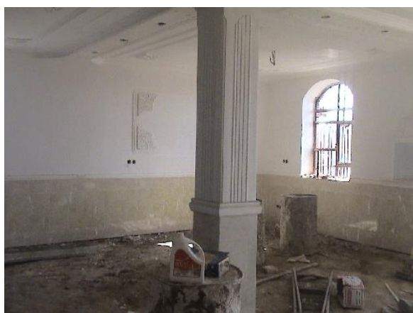
شکل ۸: گچ کاری و سنگ‌کاری نمای داخل خانه
