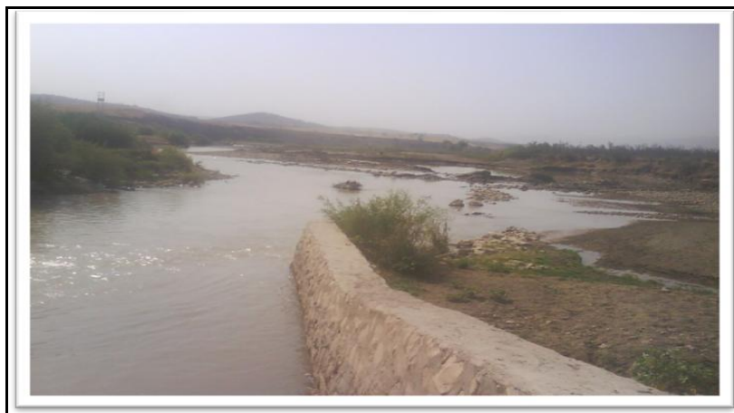
شکل ۹- ساخت سرریز بتنی و تغییر جهت مسیر رودخانه به علت ایستگاه پمپاژ آب در محل خمیدگی شماره پنج
