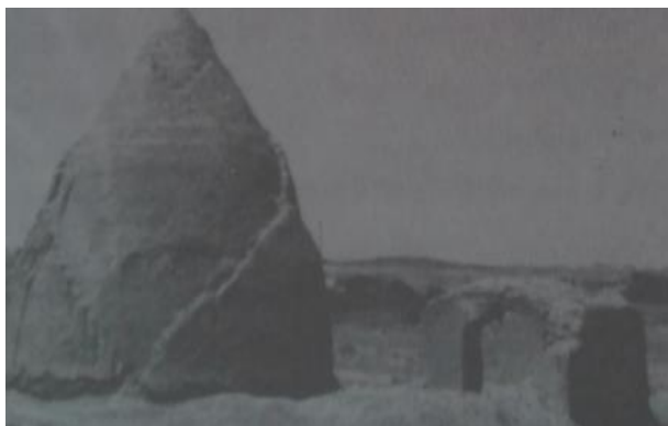
شکل ۵: نمونه ای از یخچال بدون دیوار سایه انداز شاهرود
