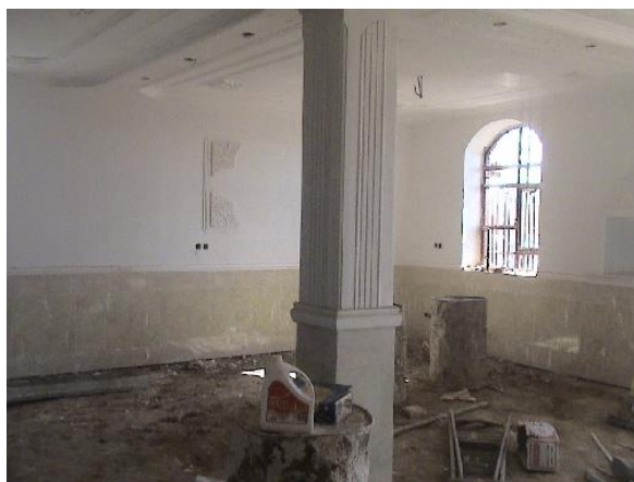
شکل ۸: گچ کاری و سنگ‌کاری نمای داخلی خانه
