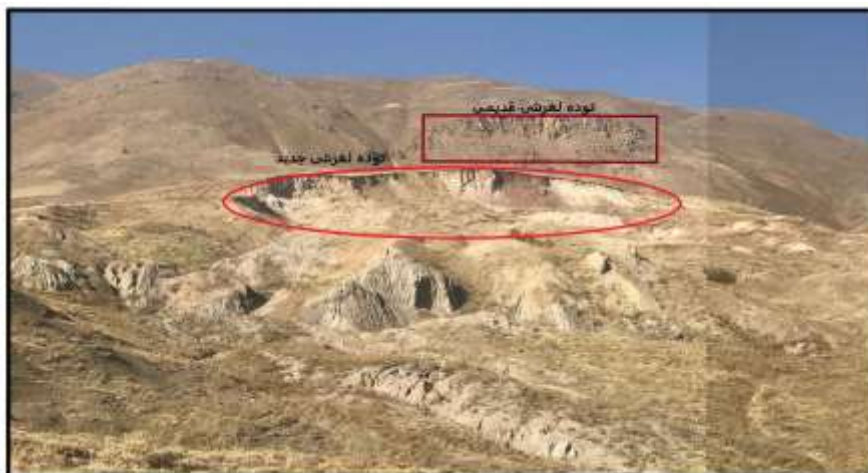
شکل ۲۳: ناپایداری‌های دامنه‌ای در روستای آوین - افضل آباد - بناروان
