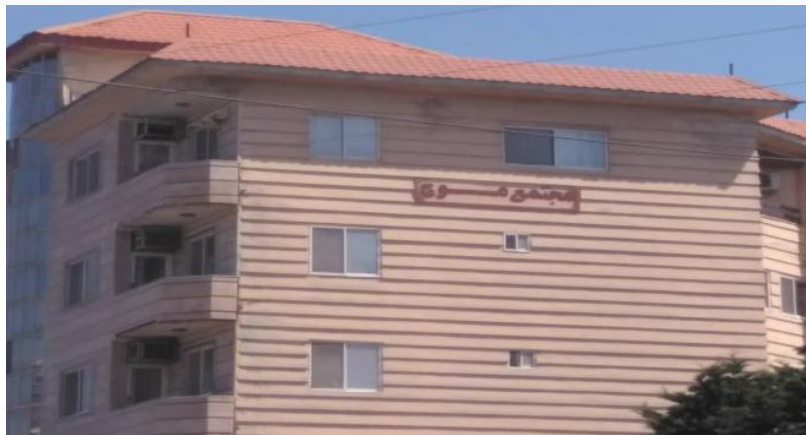
شکل ۱۶: جهت جنوبی سقف سفالی در محدوده پژوهش
