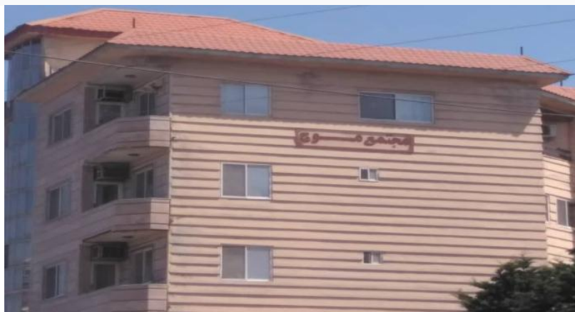
شکل ۱۶: جهت جنوبی سقف سفالی در محدوده پژوهش
