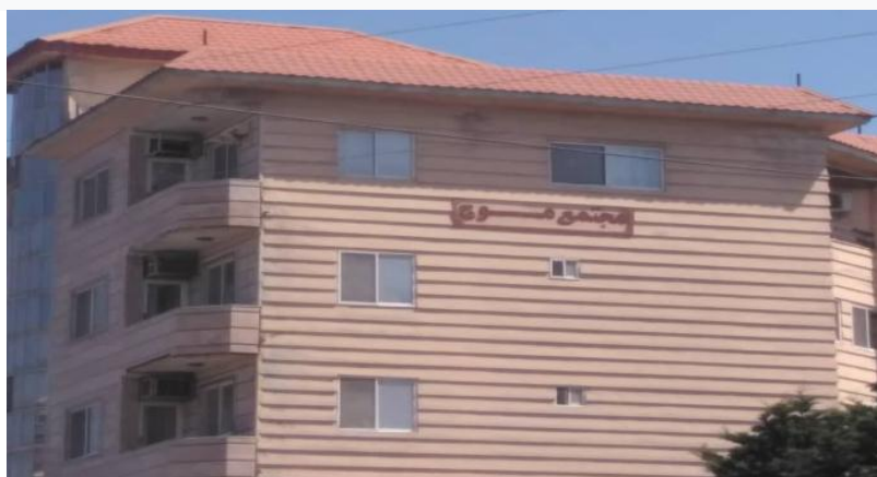
شکل ۱۶: جهت جنوبی سقف سفالی در محدوده پژوهش
