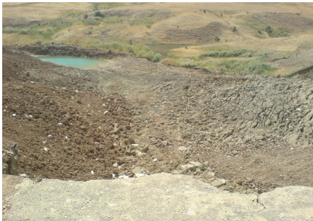
شکل ۹- لغزش زمین غرب پیرانشهر
